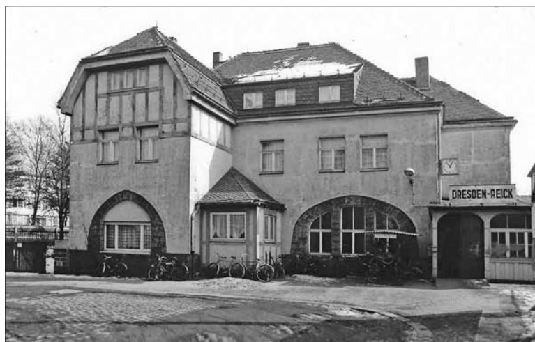
Empfangsgebäude im damaligen bescheidenen Umfeld, mit Dienstwohnung in der ersten Etage Foto: L. Kuhne
