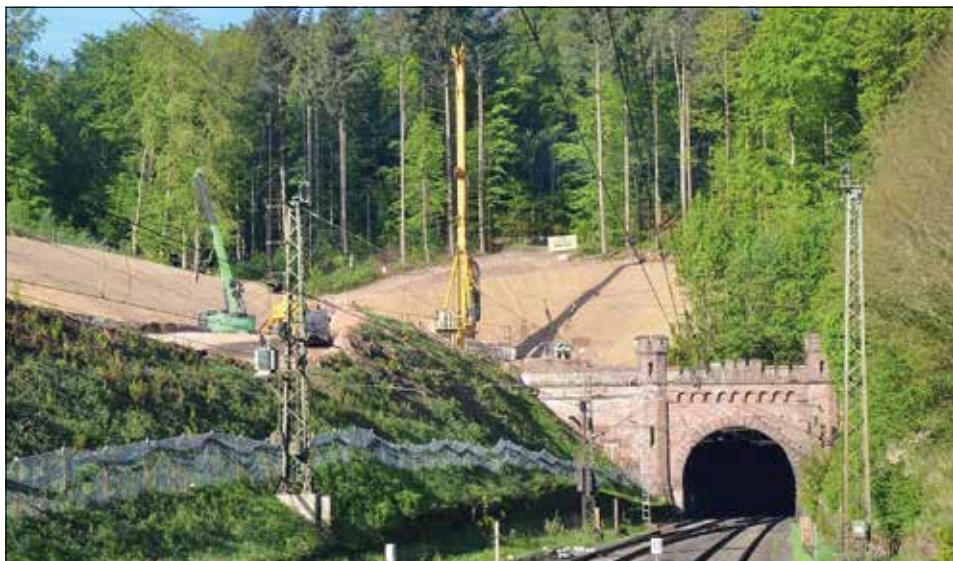
Altes Ostportal aus Richtung Eschwege mit Neubaustelle links daneben
