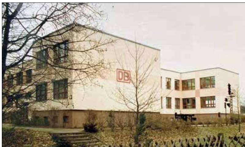
DB-Schulgebäude des TZ Güstrow
