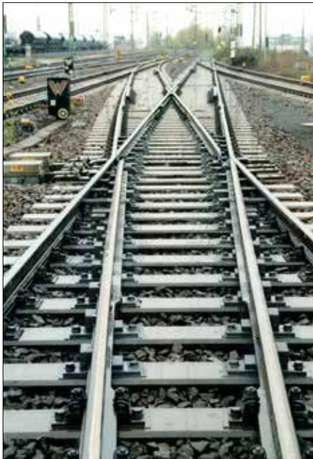
Flachkreuzung der Neigung 1:14 mit beweglichen Doppelherzstücken im „ehemaligen“ Verschiebebahnhof Engelsdorf bei Leipzig Sammlung Schmidt
