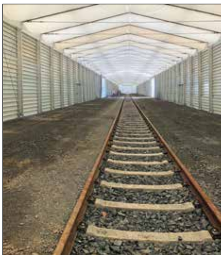
Innenansicht der noch leeren Leichtbauhalle, in die der restaurierte, sechsteilige Triebzug (2 Steuer- und 4 Mittelwagen) geradeso hinein passt.
