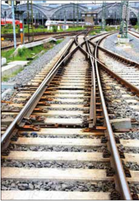
Einfache Außenbogen-Kreuzungsweiche (EABKW) in Leipzig Hbf – Das Bogengleis (Grundform EKW 54-500-1:9) wurde hier zur Geraden. Sammlung Schmidt
