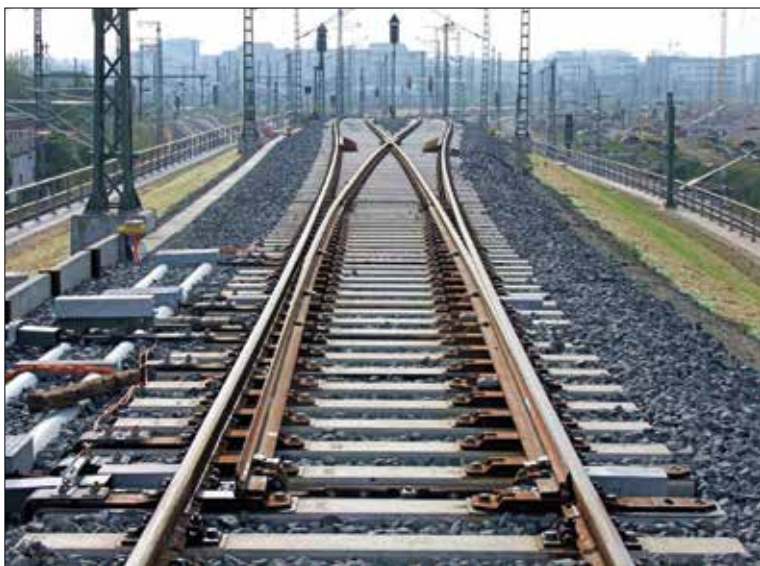
Außenbogenweiche der Grundform EW 54-760-1:14- Fsch (B) in Leipzig Hbf Sammlung Schmidt
