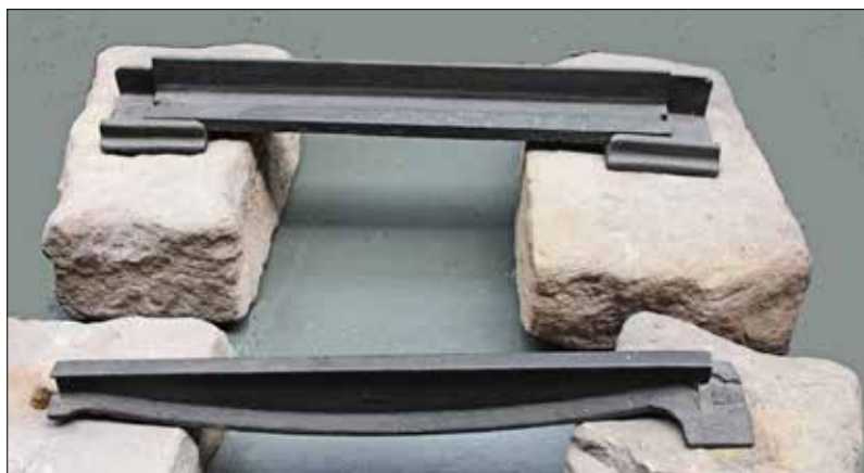
Winkelschiene oben und Fischbauchschiene unten
