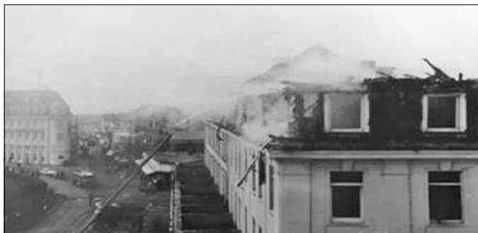
Inselhotel „Rote Erde“ nach dem Dachstuhl- brand 1975
