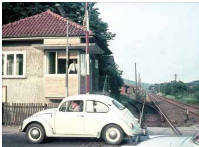
Stellwerk „Nr“ im Bahnhof Northeim um 1966, nach links zweigt der Anschluss Rhumemühle ab
