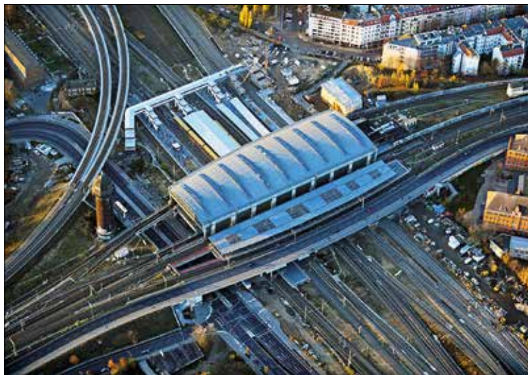
Bahnhof Berlin Ostkreuz 2018 nach dem Umbau, untere Ebene Bahnsteige der Stadtbahn und neue Fußgängerbrücke, obere Ebene neue Ringbahnhalles und ganz außen neue Bahnsteige für Regional- und Fernzüge Foto: DB Netz AG
