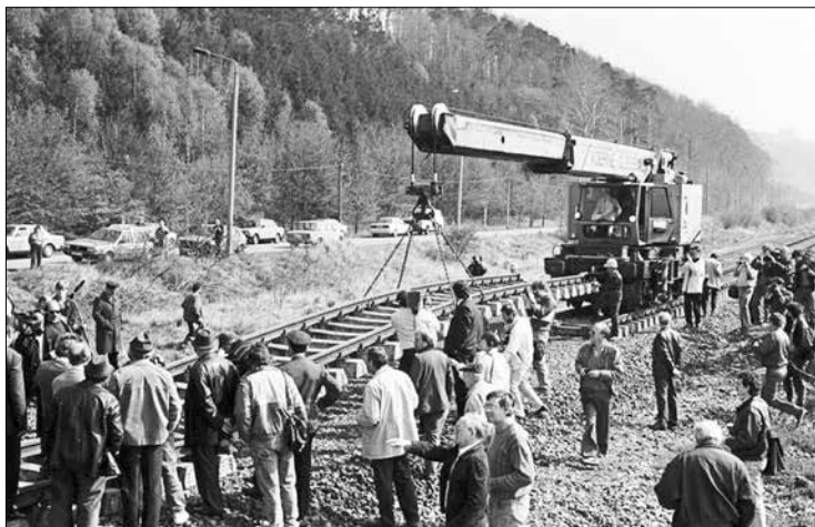
Das erste Gleisjoch symbolisiert am 26. April 1990 den Lückenschluss zwischen Wartha und Gerstungen
