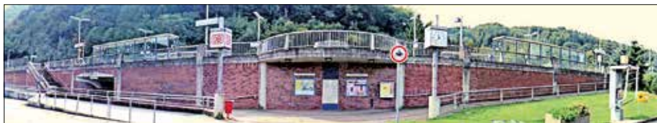
Haltepunkt Ems West mit oben liegenden Gleisen, nach dem Umbau 1999
