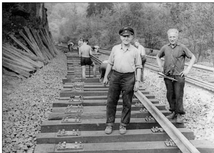
Mein Vater und ein Sicherungsposten 1964 beim Verlegen von Schienen auf der Strecke Dresden–Freiberg
