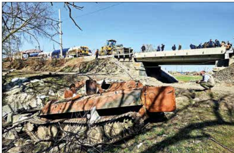
Wiederaufbau einer zerstörten Brücke
