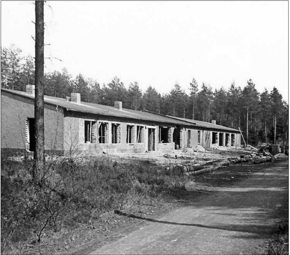
Die ehemaligen Lagerhallen der Munitionsanstalt Espelkamp werden 1945/46 zu Wohneinheiten für Flüchtlinge ausgebaut. Foto: www.muehlenkreis.de/Staette-Gemeinden/Espelkamp/
