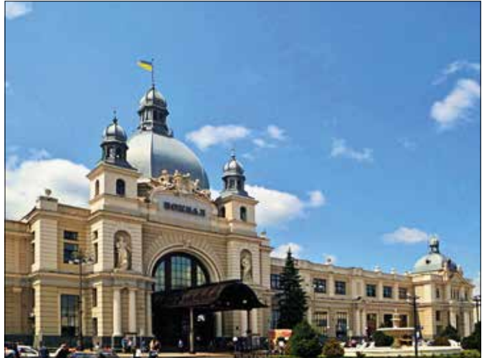
Empfangsgebäude des Bahnhof Lviv (Lemberg) Quelle: https://upload. wikimedia.org/wikipedia/commons/8/8c/ Lvivskyi_vokzal.jpg
