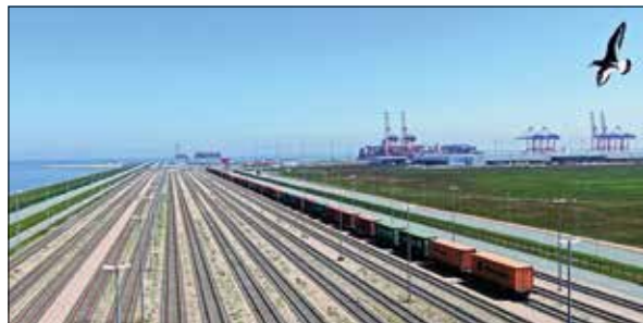
Die 16-gleisige Vorstellgruppe der Hafenbahn hat die Funktion eines Puffers zwischen dem Containerhafen und dem Hinterland. Bis zu zwölf Züge á 750 Meter können hier zeitgleich abgefertigt werden. Foto: Jade-Weser-Port
