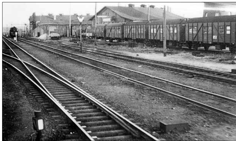
Teile des Bauzugs 1201 in den 1960er Jahren vermutlich im Bahnhof Elsterwerda. Sammlung Piehler (5x)
