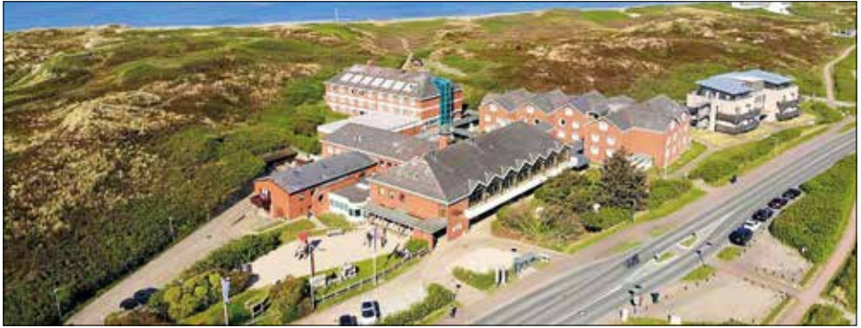
Das BSW-Dünenhotel Alt Rantum in seiner heutigen Ausbauf orm, links vorn Wirtschaftsgebäude, rechts dahinter Haus „Hamburg“, links davon mit Außenaufzug Haus „Wuppertal“ und ganz rechts der futuristische Neubau des Hauses „Köln“ Quelle: Stiftungsfamilie BSW/EWH
