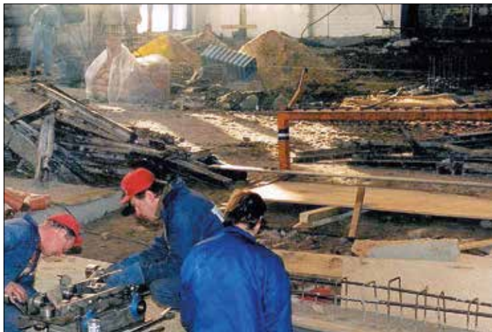
46 41 5 Betonbahn. jpg Bau der Drehgestell- werkstatt im Werk Pa- derborn
