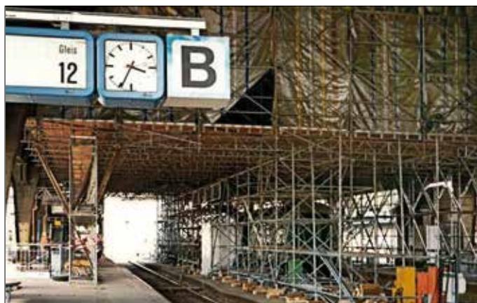
Über den Gleisen wurde über den Köpfen der Reisenden die Hallenkonstruktion gestrahlt und lackiert.
