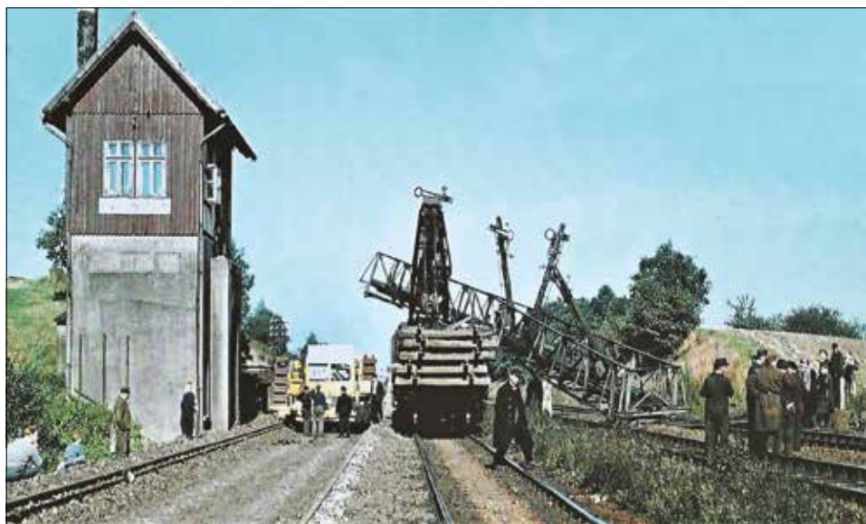
Blockstelle Stedefreund bei der Bäumung der Signalbrücke 1962
