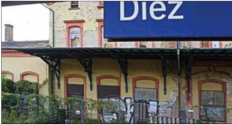
Zugenageltes Empfangsgebäude im Bf Diez (Kreis Limburg-Weilburg) Quelle: Frankfurter Neue Presse vom 25. Okt. 2015
