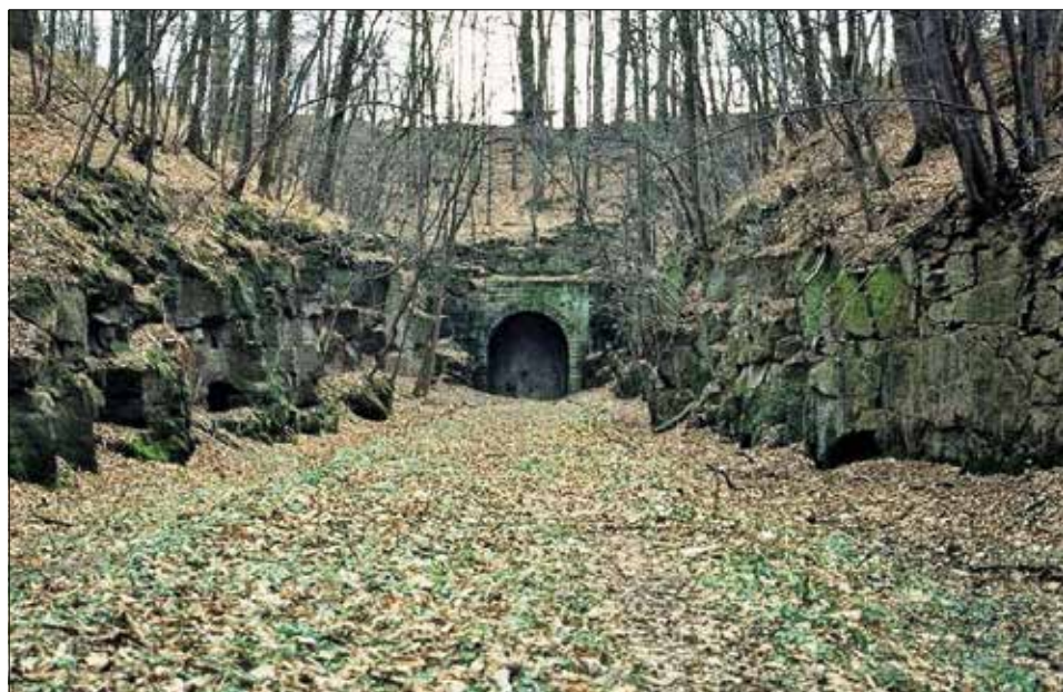
Trasse von Großcotta mit Tunnelportal (km 8,3) am 12. Februar 2001
