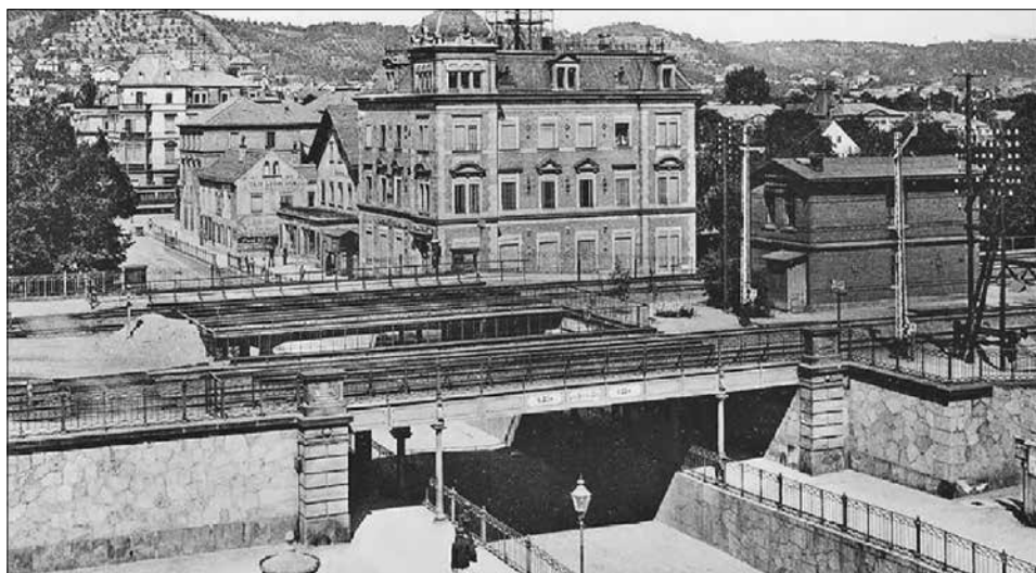
Die hochgelegte Strecke Leipzig–Dresden mit der Brücke in Kötzschenbroda um 1900 (ab 1941 Radebeul West, ab 2013 Radebeul-Kötzschenbroda) Sammlung: Kuhne
