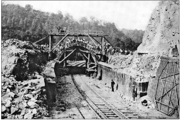
Bahnstrecke Dresden–Tharandt, Rückbau des Tunnels Felsenkeller am Westportal 1895 Sammlung Kuhne
