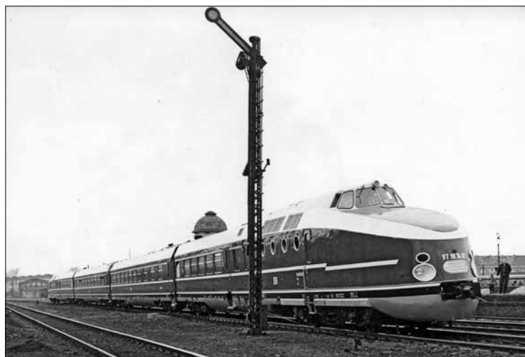
Diesel-Schnelltriebwagen VT 18.16.02 Bauart Görlitz in Originallackierung als „Vindobona“ Berlin–Prag–Wien Aufnahme: 1968 Hans-Joachim Kirsche
