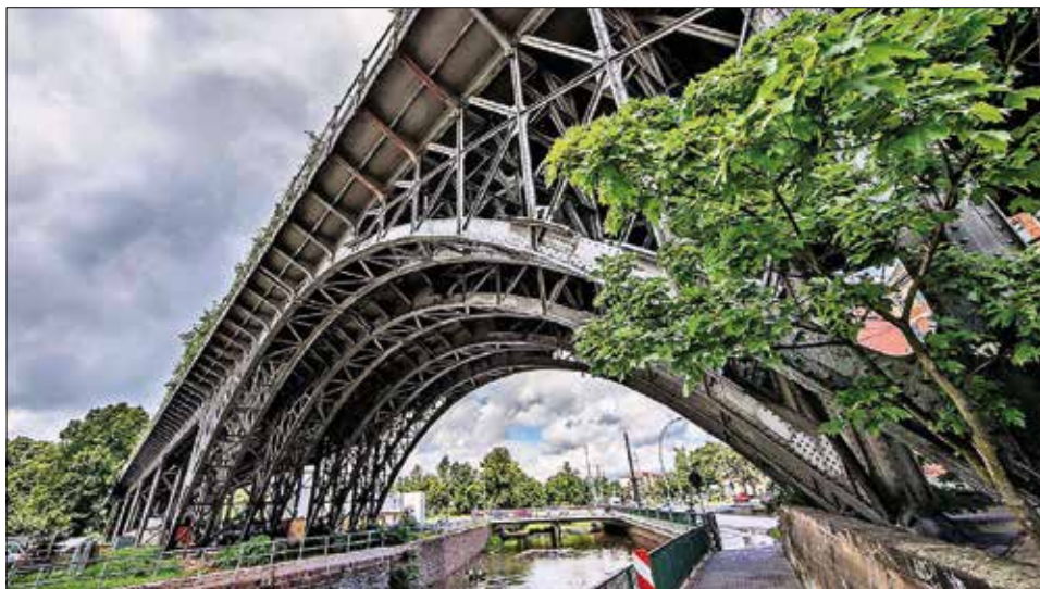
1909 wurde der Chemnitzer Viadukt auf der Annaberger Straße fertiggestellt.
