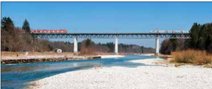
Der Neubau der Großhesseloher Brücke als stählerne Fachwerkbrücke im Jahr 2009 Quelle: München-Wiki
