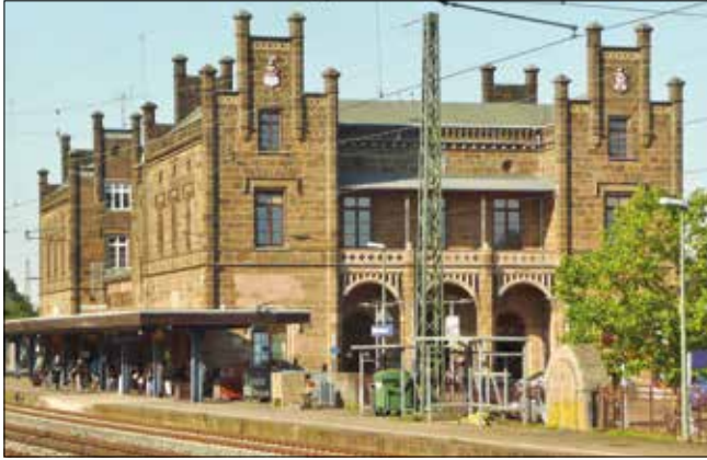
Das Empfangsgebäude des Bahnhofs Minden 2013
