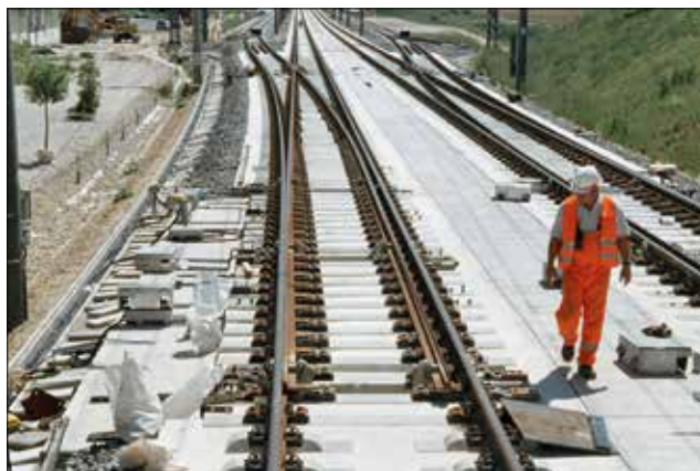
Endmontage einer Hochgeschwindigkeits-Weiche mit drei Verschlüssen Foto: DB AG / Claus Weber
