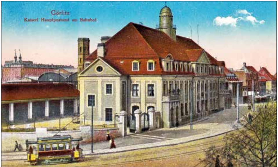
Bahnhof Görlitz in der Umbauphase 1917 – hinter dem Hauptpostamt schauen noch die beiden Türme des alten Empfangsgebäudes in Insellage hervor, während rechts an der Bahnhofstraße halb verdeckt am neuen Empfangsgebäude in Seitenlage gebaut wird. Die ersten beiden Bahnsteighallen sind bereits fertig. Sammlung Rettig
