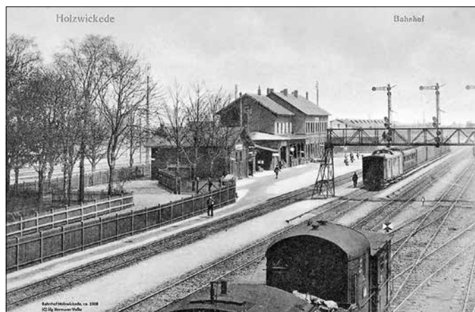
Bahnhofsgebäude Holzwickede 1908 (abgerissen 1994), Blick Richtung Unna Sammlung: H. Volke
