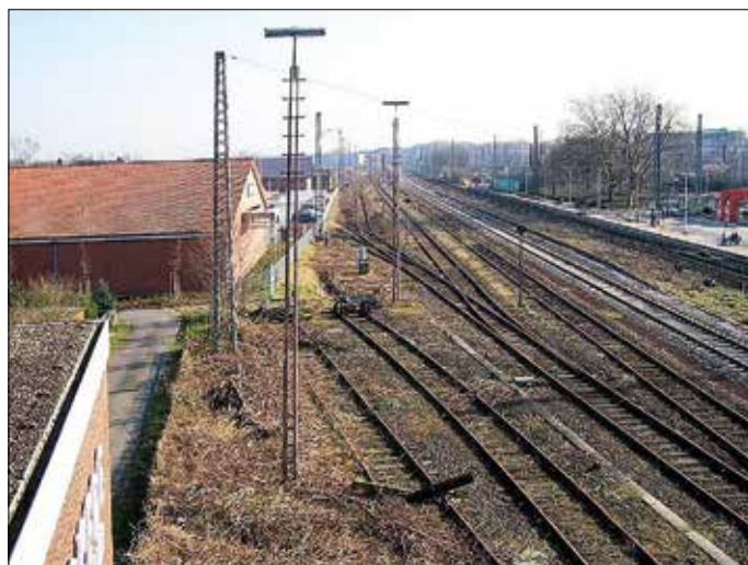
Nordteil des Bahnhofs Holzwickede 2015 Richtung Unna, mit den Gleisen 205-209 (v.r.n.l.) Die Gleisstummel (vorn Mitte) enden kurz vor dem neugebauten Rewe-Markt. Foto: H. Volke
