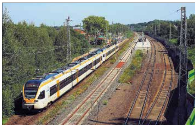
Südteil des Bahnhofs Holzwickede 2015 Richtung Unna, mit den Gleisen 201-204 (v.r.n.l.) Auf Gleis 204 fährt die Eurobahn nach Soest mit ET 5.05 und ET 5.07. Foto: Frank St.
