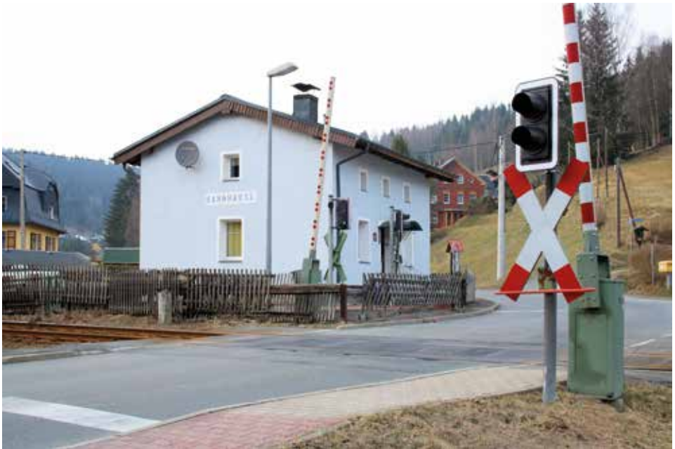
Eines der wenigen sächsischen Bahnwärterhäuser III. Klasse, das die Zeiten als saniertes „BAHN-HÄUSLE“ überdauert hat. Foto: Rainer Heinrich
