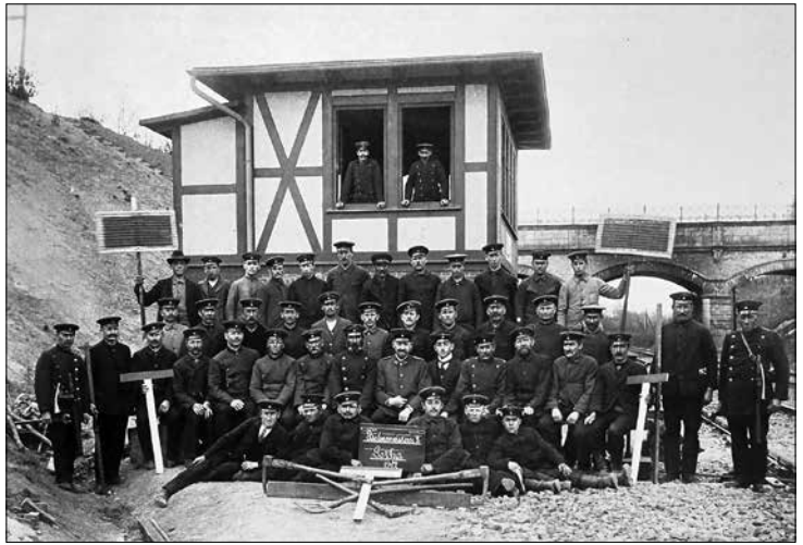
Gruppenbild der Bahnmeisterei 2 Gotha beim Um- bau der Blockstelle Leinakanal 1912
