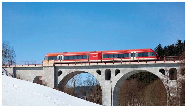
Diesellokomotive der BR VT 646 (Stadler Gelenktriebwagen GTW 2/6) der Kurhessenbahn von Korbach nach Brilon-Wald auf dem Viadukt bei Rhena im Winter
