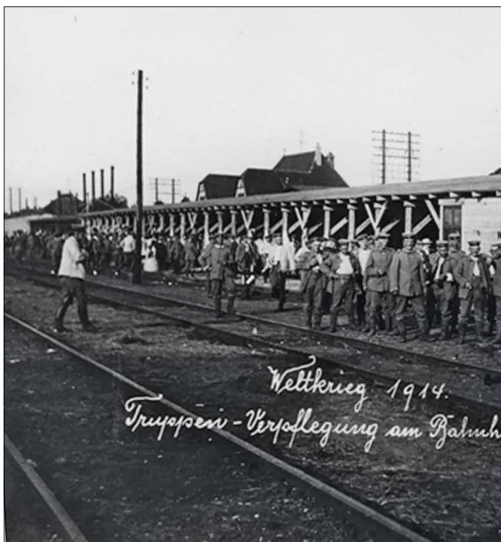
Auf der Ladestraße des Bahnhofs Gütersloh waren sehr schnell mehrere Holzhallen für die Truppenverpflegung aufgebaut worden.
