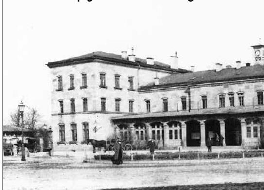
Betriebshauptgebäude Bf. Bamberg um 1885
