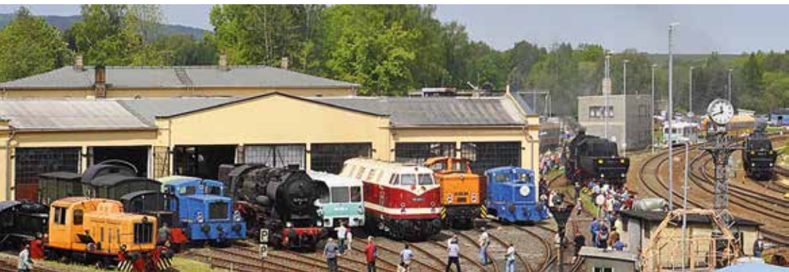
Das 1859 erbaute Maschinenhaus Löbau an einem Tag der offenen Tür
