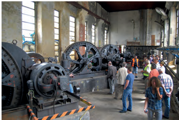
Drei Seil-Antriebsmaschinen von 1930 und das umgebende Gebäude warten noch auf Sponsorengelder und Rekonstruktion
