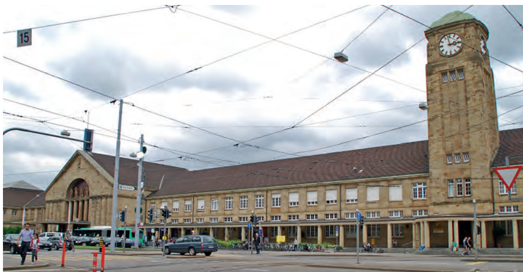
Basel Bad Bf - Empfangsgebäude an der Schwarzwaldallee im Juni 2013
