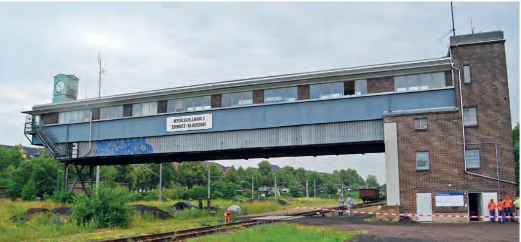
Befehlsstellwerk 3 über den Ablaufgleisen im Juli 2013
