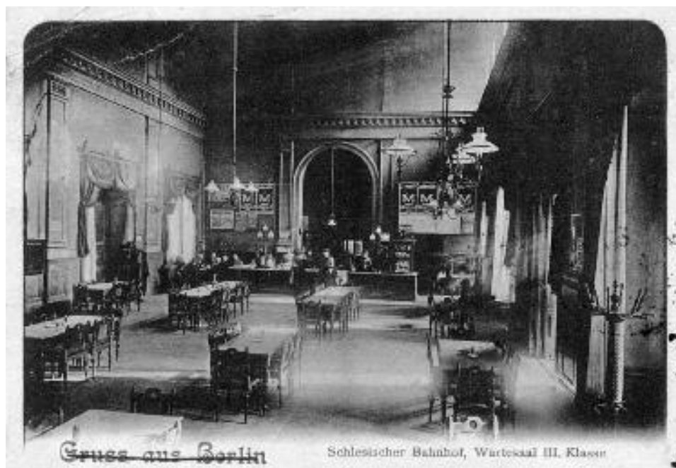
Stellvertretend für alle bewirtschafteten Wartesäle der damaligen Zeit soll die Ansicht vom Schlesischen Bahnhof in Berlin sein, die den dortigen Wartesaal III. Klasse um 1900 zeigt.
