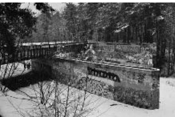
Das große Widerlager mit Kastenbrücke ist die Stammbahnbrücke über die alte Transitautobahn in Dreilinden
