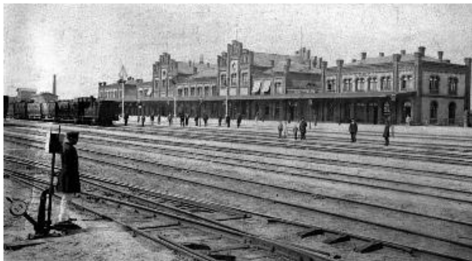
Der „Centralbahnhof“ Stendal wurde zwischen 1868 und 1871 am südwestlichen Stadtrand erbaut und im Dezember 1871 vollständig in Betrieb genommen. Im Bereich der beiden Querriegel befanden sich die Wartesäle. Das Fürstenzimmer lag unmittelbar links neben dem linken Querriegel.
