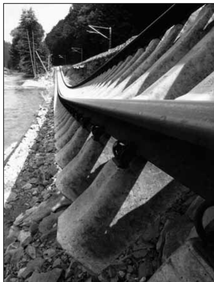
Die soeben rekonstruierten Hauptgleise bei Tharandt am 13. August 2002 – die Wilde Weißeritz unterspülte große Abschnitte der Strecke Dresden–Chemnitz
