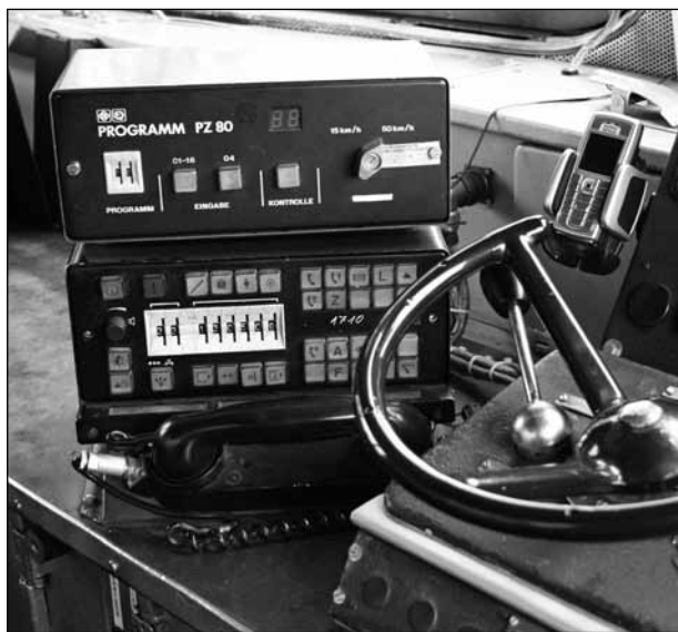
Fest eingebaute digitale Zugfunkstation MESA 2002 (unten) auf einer Lok BR 234, darüber die Indusi PZ 80
