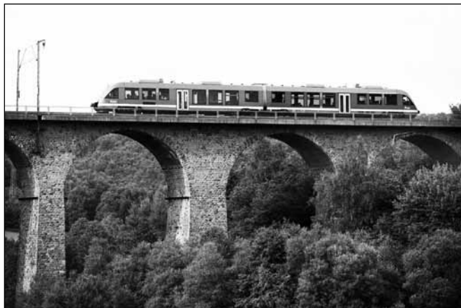
Ein Triebwagen der DreiländerBahn überquert 2005 den Rudersdorfer Viadukt zwischen Siegen und Dillenburg. Das Bauwerk besteht aus acht Rundbögen und wurde 1915 fertiggestellt.
