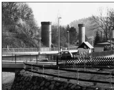
Zwei der zehn Betonpfeiler des ehemaligen Robschützer Viadukts (mit 208 Metern Deutschlands längste Schmalspurbahnbrücke) im Jahr 2008 Foto: Dähne
