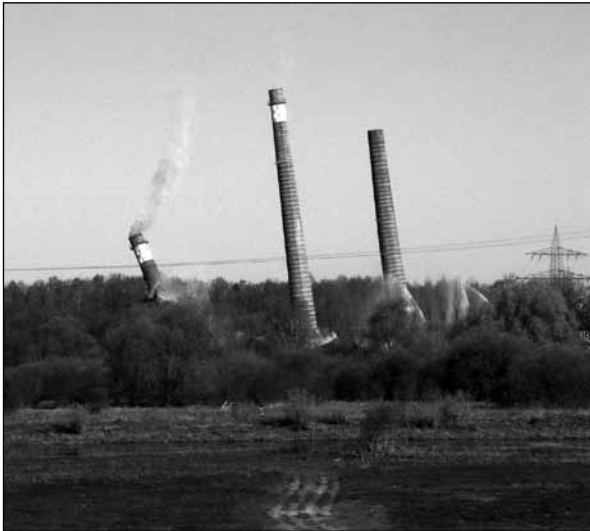
Bahnkraftwerk Muldenstein; Schornsteine 1, 2 und 3 während der Sprengung am 10. April 2011 Foto: Stephan
