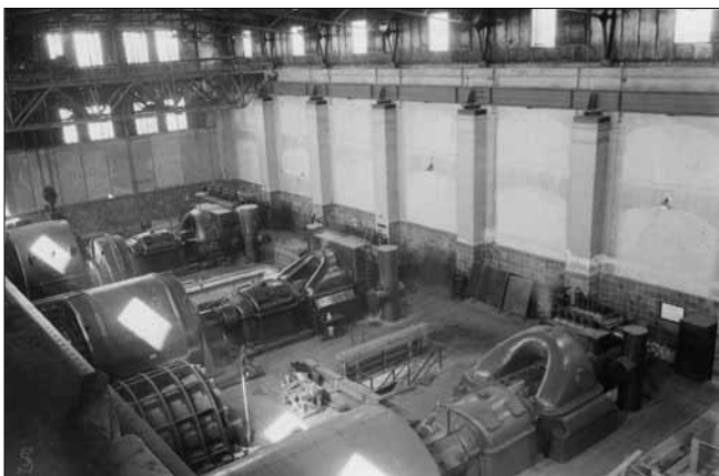
Innenansicht Maschinenhaus am 15. Juli 1941, vorne links die beiden 10-MW-Turbogeneratoren, von denen die Turbinen nicht wieder aufgebaut wurden Foto: Hist. Slg. DB AG
