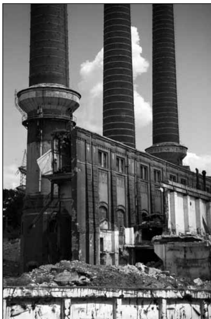
7. Juni 2008: Abrissarbeiten Bahnkraftwerk Muldenstein; die interessante Klinikfassade ist noch gut zu erkennen
