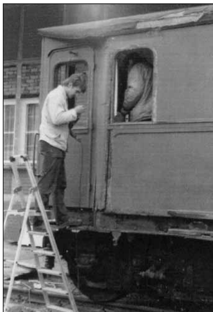
Rene Litzkowsky bei der Renovierung
