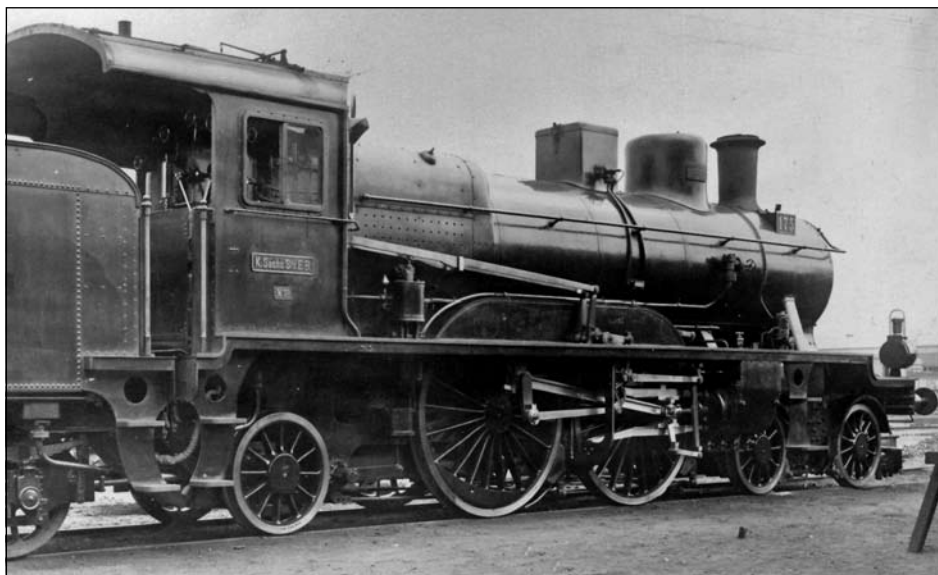
▲ Zwischen 1900 und 1903 baute Hartmann für die Königlich Sächsischen Staats-Eisenbahnen 15 Maschinen der Bauart 2'B1' n4v (Gattung H V). Die Bahn-Nummer 175 wurde bei der DRG zur Betriebsnummer 14 202. Die Maschine erhielt auf der Weltausstellung 1900 in Paris den Grand Prix.
