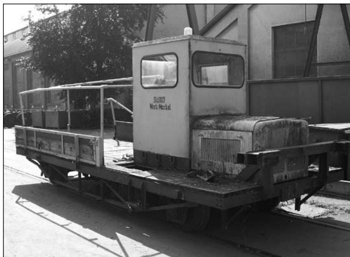
◀ Der KLV 51 muss wieder fahrbereit werden.
