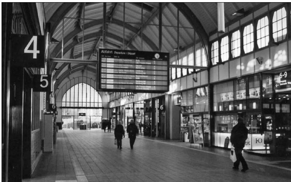
▲ Die in neuem Glanz erstrahlende Bahnhofshalle des Lübecker Hauptbahnhofs
