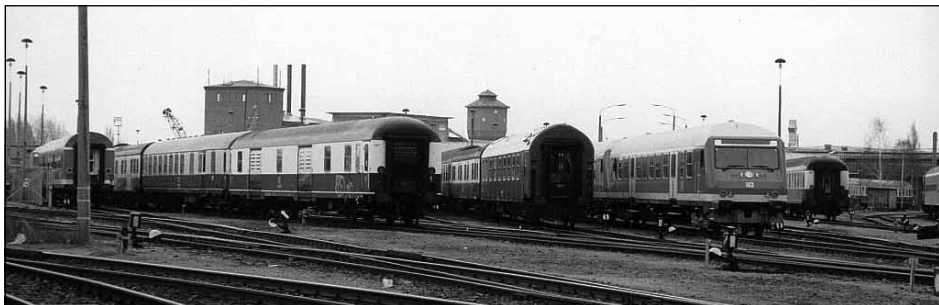
▲ Bildausschnitt vom Werksgelände mit Blick in Richtung Kraftwerk und historischen Wasserturm, aufgenommen im März 1998. Foto: Thomas Dießner
