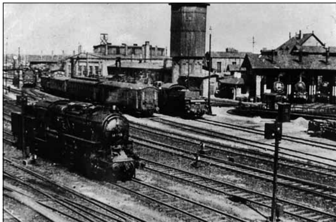
▲ Bahnbetriebswerk mit Lokschuppen I
