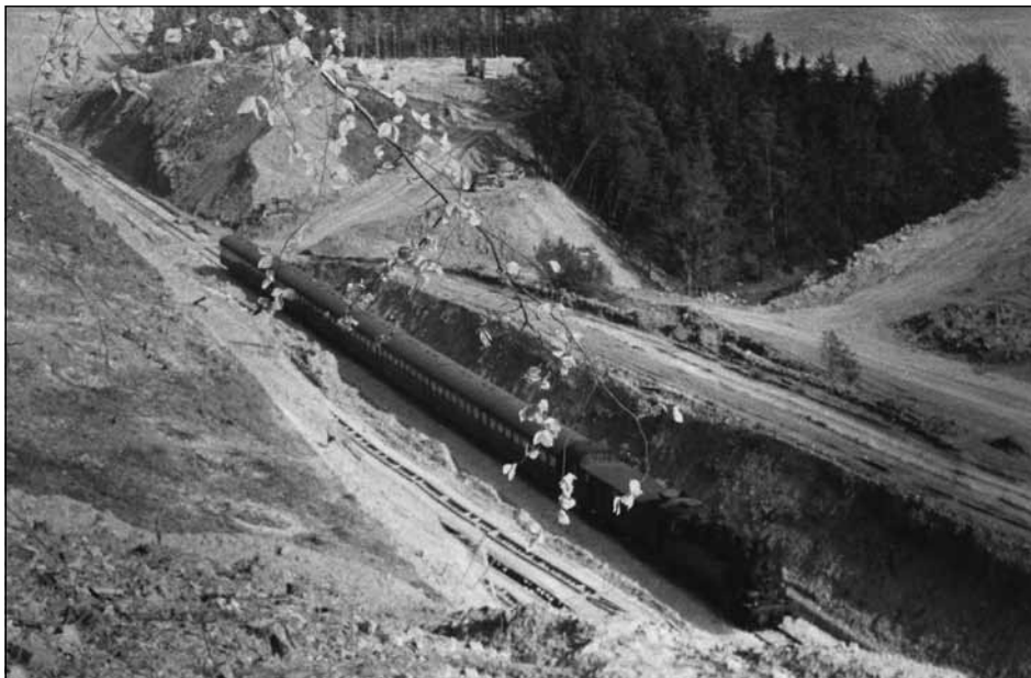
▲ Der erste Zug auf der neu erbauten Strecke zwischen Förtha und Gerstungen verkehrte am 13. April 1962.
